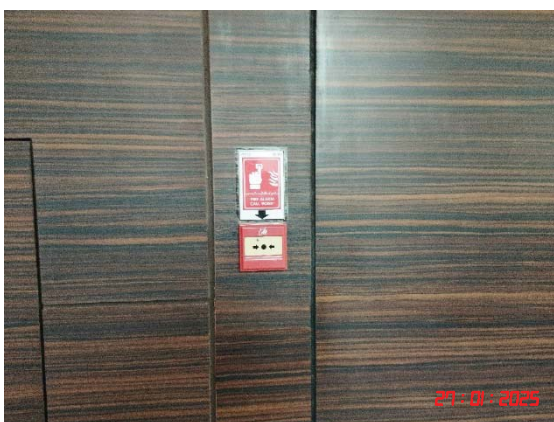
อุปกรณ์เตือนภัยด้วยมือ
